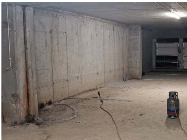
Rys. 2. Przegrody separacyjne wykonane z cementowej zaprawy szybkowiążącej (fot. własna)
