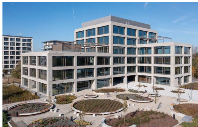
Rys. 3. Wrocław, Nowe Żerniki, biurowiec przy Al. Architektów, autorstwa pracowni projektowej Maćków; uwagę przykuwają prefabrykowane elementy betonowe z wyeksponowanym kruszywem, które wykonała firma Betard Sp. z o.o. (fot. dzięki uprzejmości firmy Betard Sp. z o.o.)
