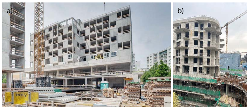
Rys. 4. Plac budowy budynku nr 3 osiedla mieszkaniowego CentralPark w Gdańsku. Projekt: MWH Architects, A. Wyszyński, A. Piętocha, 2025 r. (a), plac budowy osiedla mieszkaniowego Growing House, Zhengzhou, China, 2025 r. (b)
