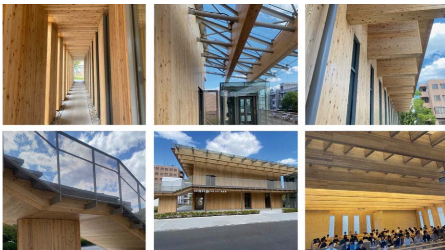
Rys. 3. „Wooden Classroom”: hybrydowa konstrukcja z drewna (CLT), stali i szkła jako przykład projektowania cyrkularnego w obiekcie dydaktycznym (źródło: Vaverková, Okayama, 2023)
