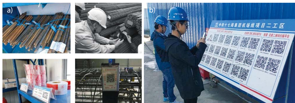
Rys. 5. Wykorzystanie kodów QR do zarządzania placem budowy w China Construction Third Engineering Bureau Group Co., Ltd., (a), źródło: https://cli.im/client/detail/1766 , tablica z kodami QR na budowie drucznego odcinka linii lotniskowej nr 17 Grupy Biura Kolei Chińskich (b), źródło: https://www.i3vsoft.com/Mobile/uploadfiles/pictures/product/20230726172715_0338.jpg_280.jpg , dostęp: 2026-03-11
