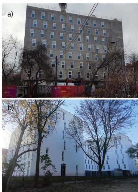
Rys. 3. Akademik Shed Campus Living: a) Elewacja z żelbetowych prefabrykatów ściennych, b) zrealizowany budynek (fot. własne)
