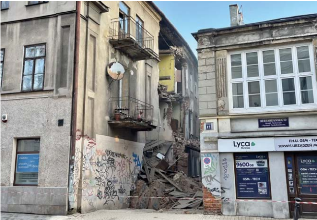
Rys. 1. Katastrofa budowlana ul. Bernardyńska 10 w Lublinie
